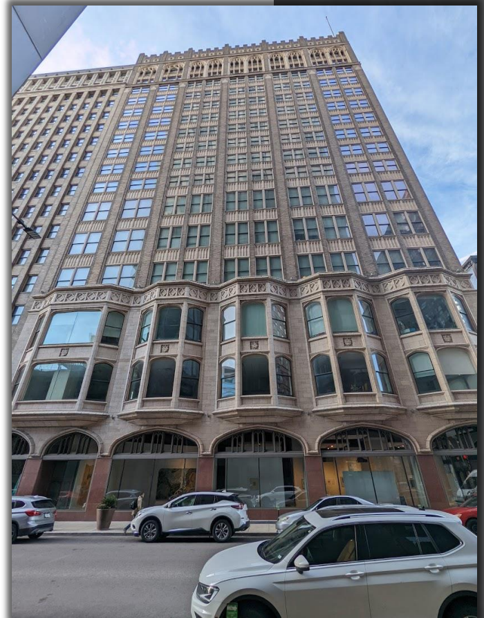
BÂTIMENT ARCADE SAINT-LOUIS, ÉTATS-UNIS
