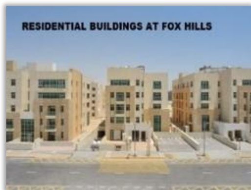
BÂTIMENTS RÉSIDENTIELS À FOX HILLS QATAR
